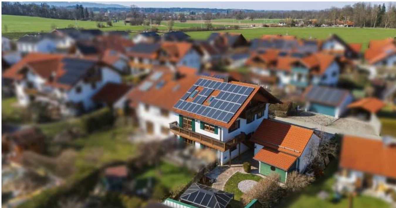
Drohnenansicht · Dachflächen mit Photovoltaik · Originalaufnahme
