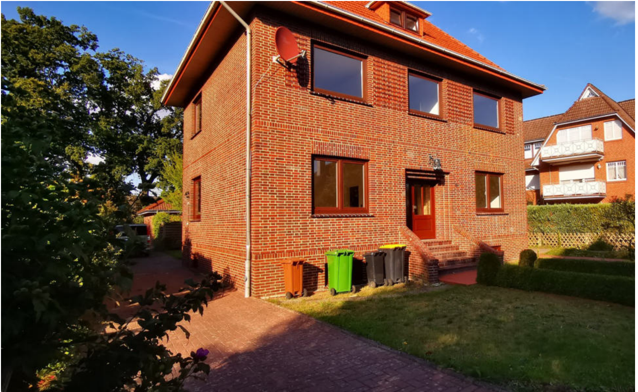
Straßenansicht von links
