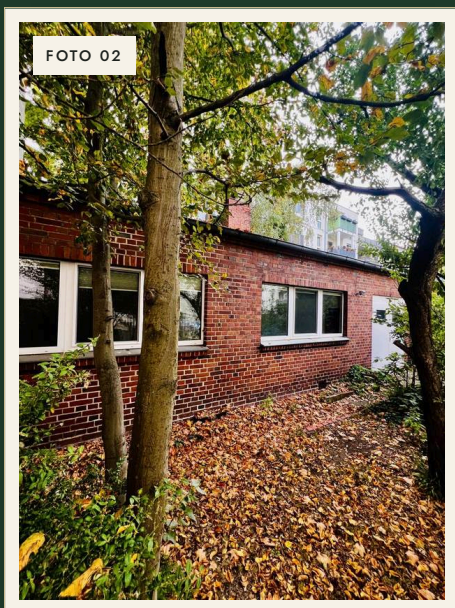
Foto 02 · Klinkerfassade unter alten Bäumen
