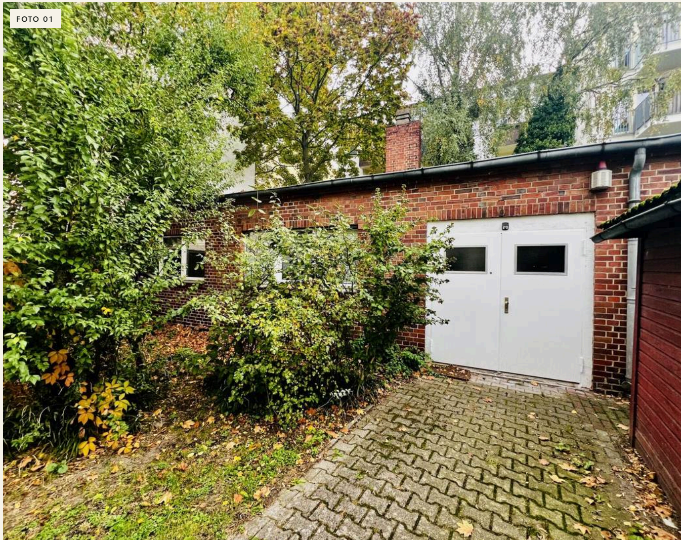
Foto 01 · Die Remise im grünen Innenhof
