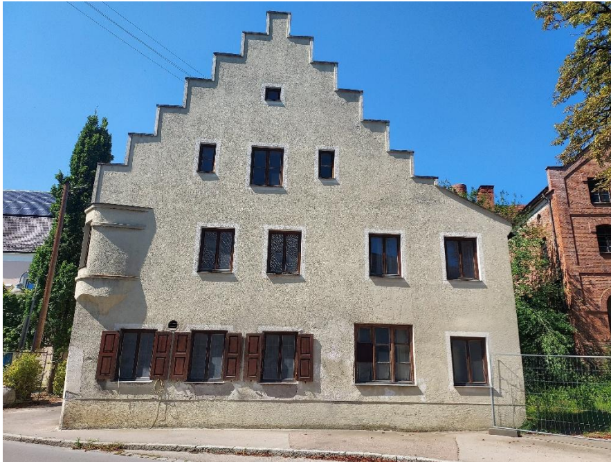
Das ehemalige Gasthaus ist ein zweigeschossiger, giebelständiger Satteldachbau mit Treppengiebel und gerundetem Erker aus dem 16./17. Jahrhundert.
