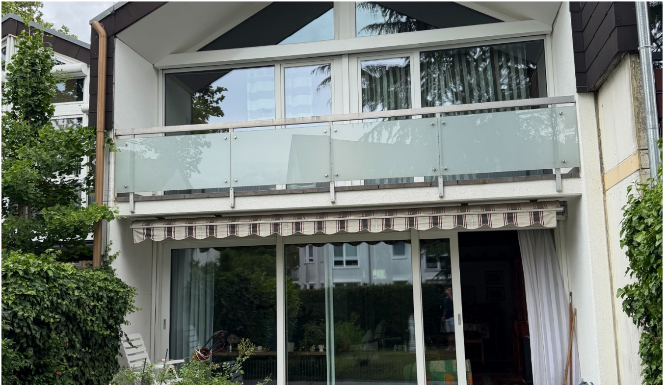
Gartenseite mit Terrasse, Balkon und großflächigen Fensteranlagen
