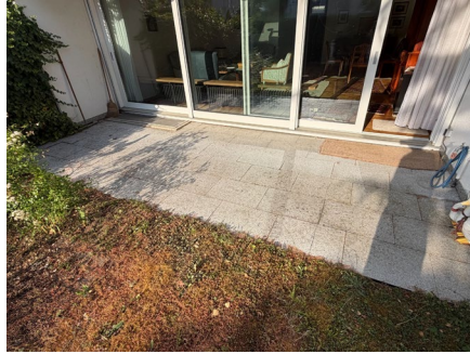
Sanierte Terrasse vor der Hebe-Schiebeanlage
