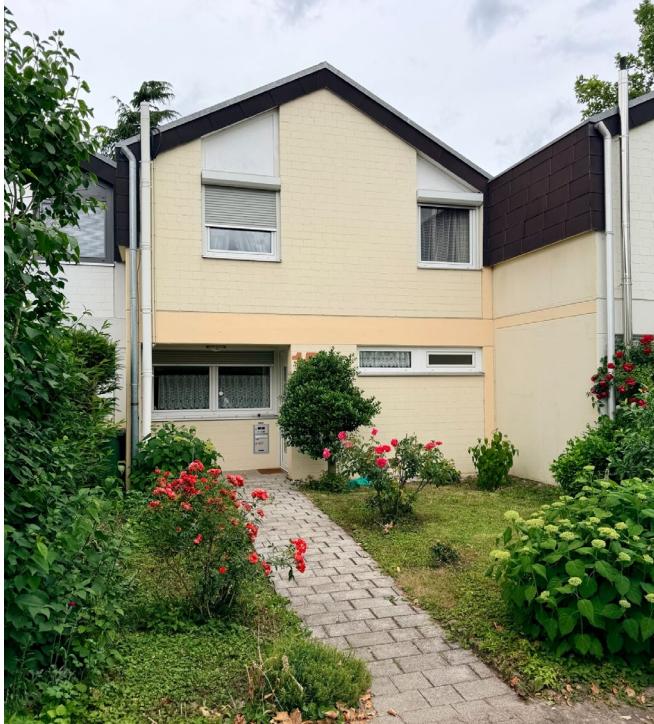
Straßenseite mit Vorgarten und geschütztem Hauseingang
