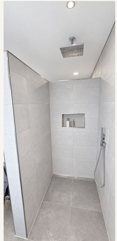
Bodengleiche Dusche im OG
