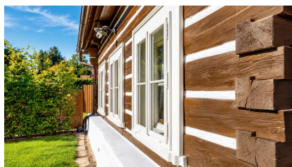
Blockwand mit originalen Fensterformaten
