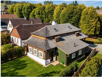
Luftaufnahme des Mansarddachs mit handgespaltenen Lärchenschindeln
