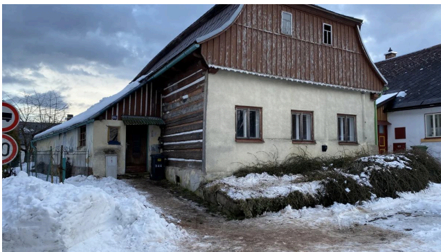
Vorher · Zustand vor der Sanierung
