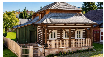
Rekonstruierte Laube und Schindeldach
