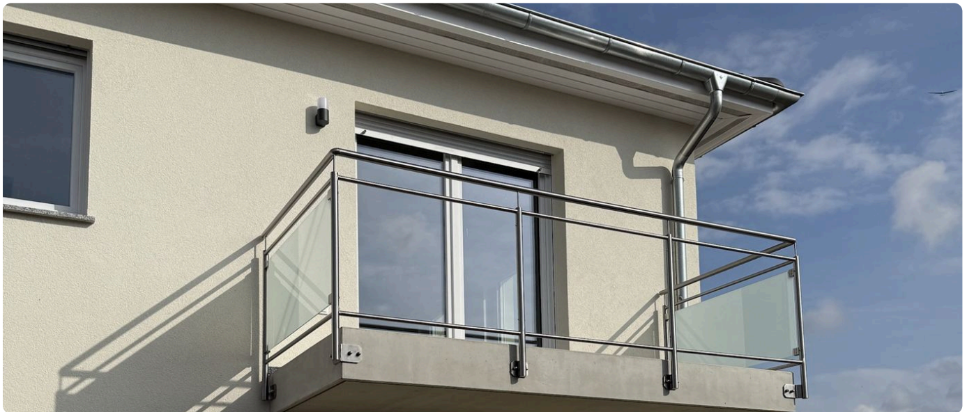
Außenansicht mit Balkon der Wohnung im Obergeschoss · Bauzustand Oktober 2026
