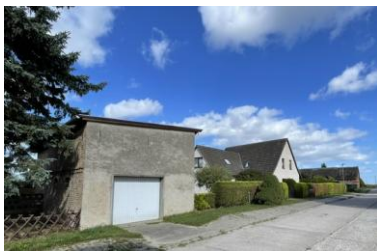
Blick von der Straße mit Garage im Vordergrund
