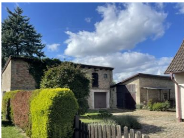
Blick von der Straße auf die Nebengebäude
