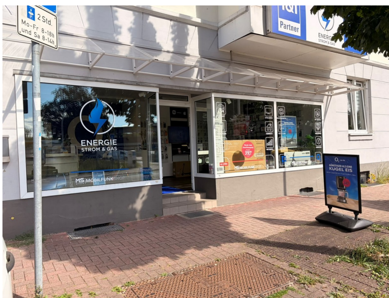
Gewerbeeinheit mit Schaufensterfront zur Bahnhofstraße
