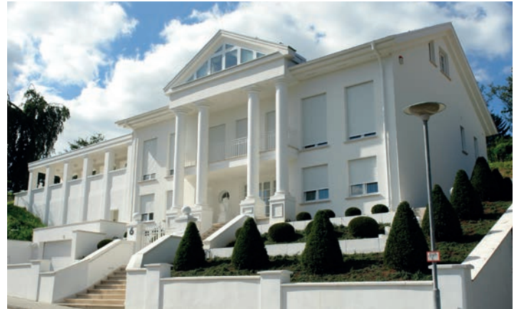
Einfamilienhaus in Goldbach
