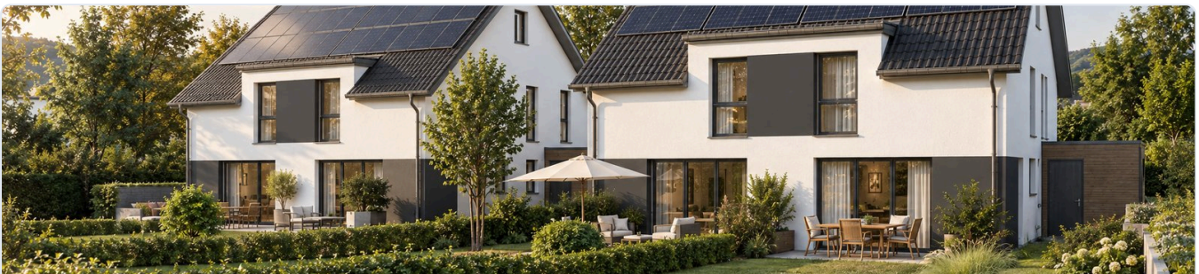
Doppelhaushälften – Gartenseite mit privaten Terrassen & Solardächern
