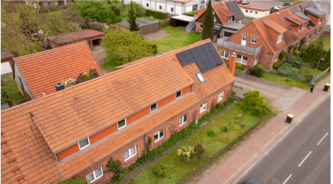
Straßenseite aus der Luft
