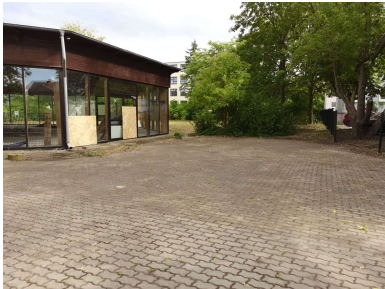
Entkernter Pavillon-Rohbau mit Parkplatz von Fichtestraße aus 2022
