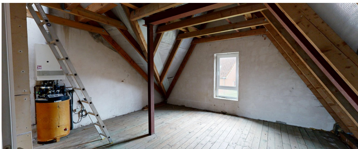
Dachgeschoss, nicht ausgebaut
