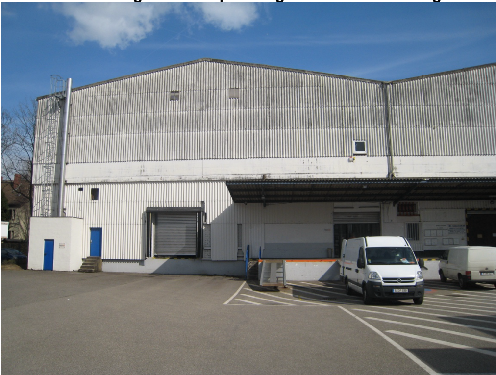
Halle 1 mit vorgelagerter Rampe
