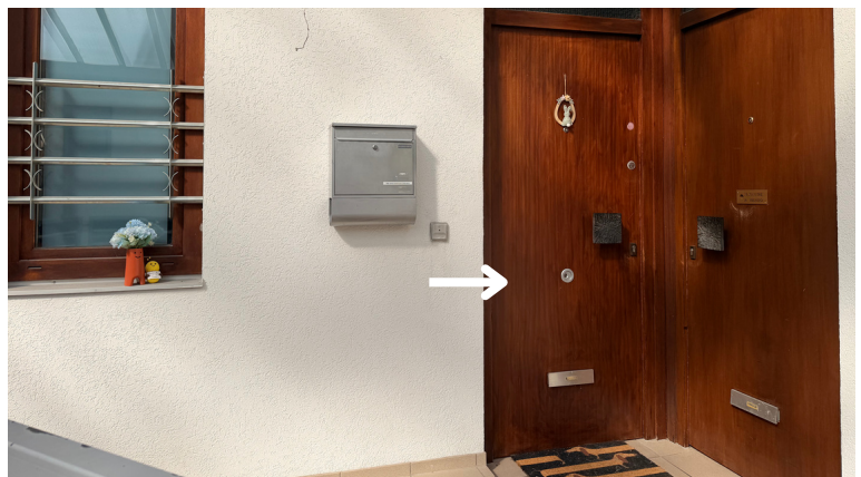
Gebäudeansicht | Eingang (3. OG)
