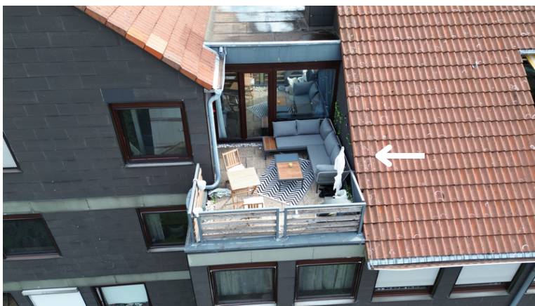
Gebäudeansicht | west (Dachterrasse)
