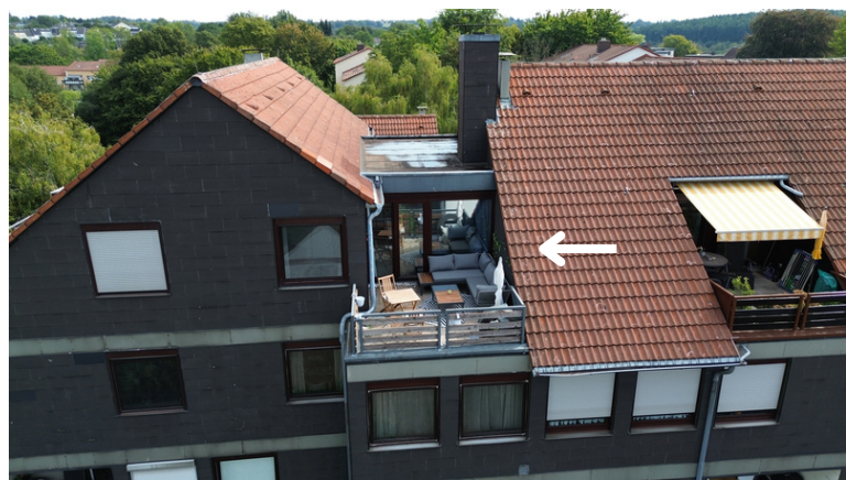
Gebäudeansicht | west (Dachterrasse)
