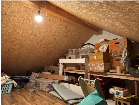
Ausgebauter Dachboden (ca. 15 m 2 Lagerfläche)
