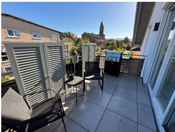
Balkon mit Keramikplatten auf Stelzlägern
