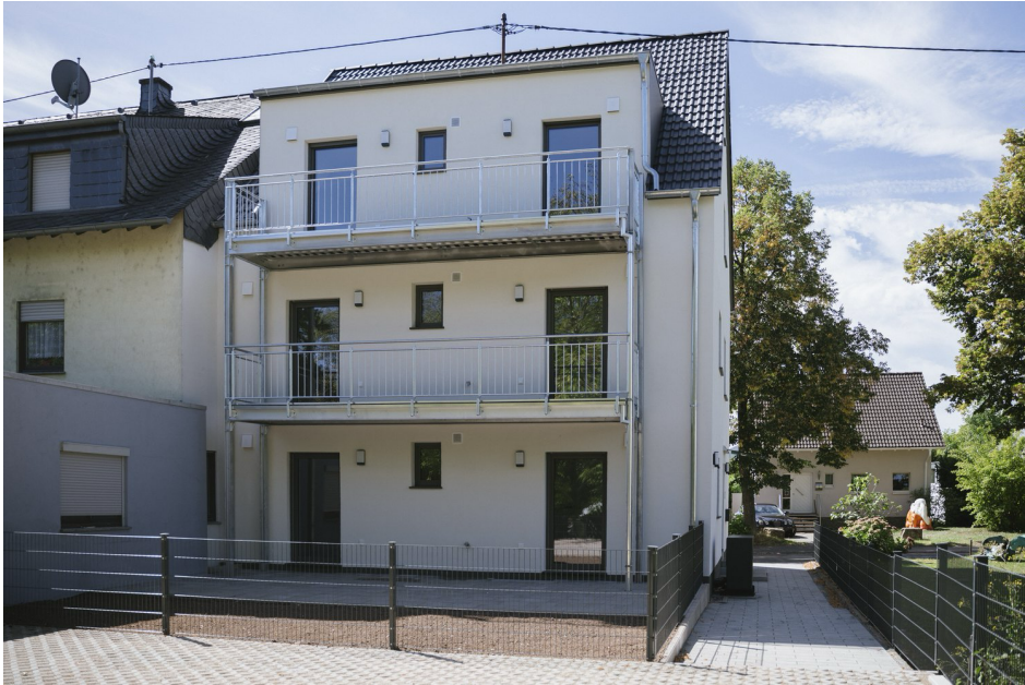
Die Gartenseite nach Abschluss der Sanierung. Der Balkon der Wohnung liegt in der obersten Ebene.
