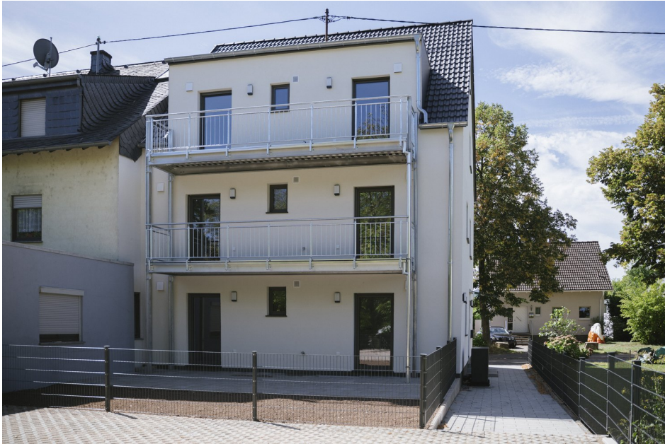
Die Gartenseite nach Abschluss der Sanierung. Der Balkon der Wohnung liegt in der mittleren Ebene.
