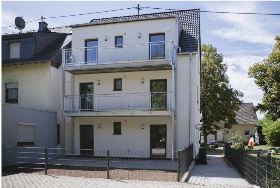
Die Gartenseite nach Abschluss der Sanierung.
