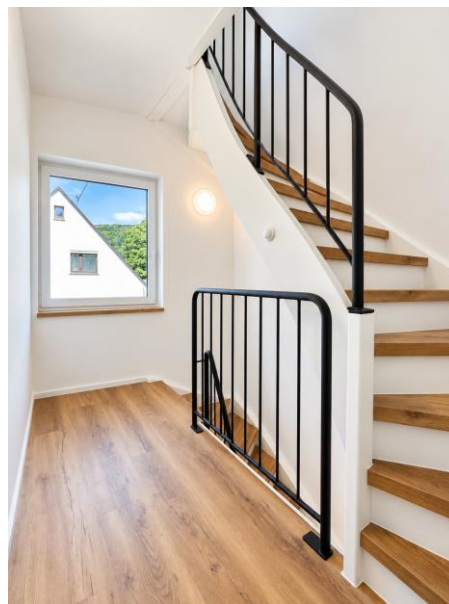
Das Treppenhaus wurde vollständig saniert.
