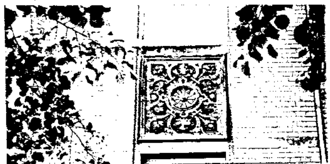
Saniertes Stilelement an einem Gebäude in Dresden-Löbtau
