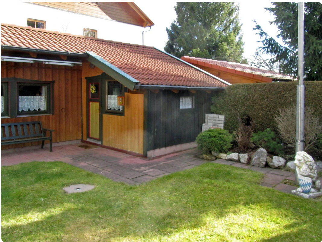
Garten mit Nebengebäude
