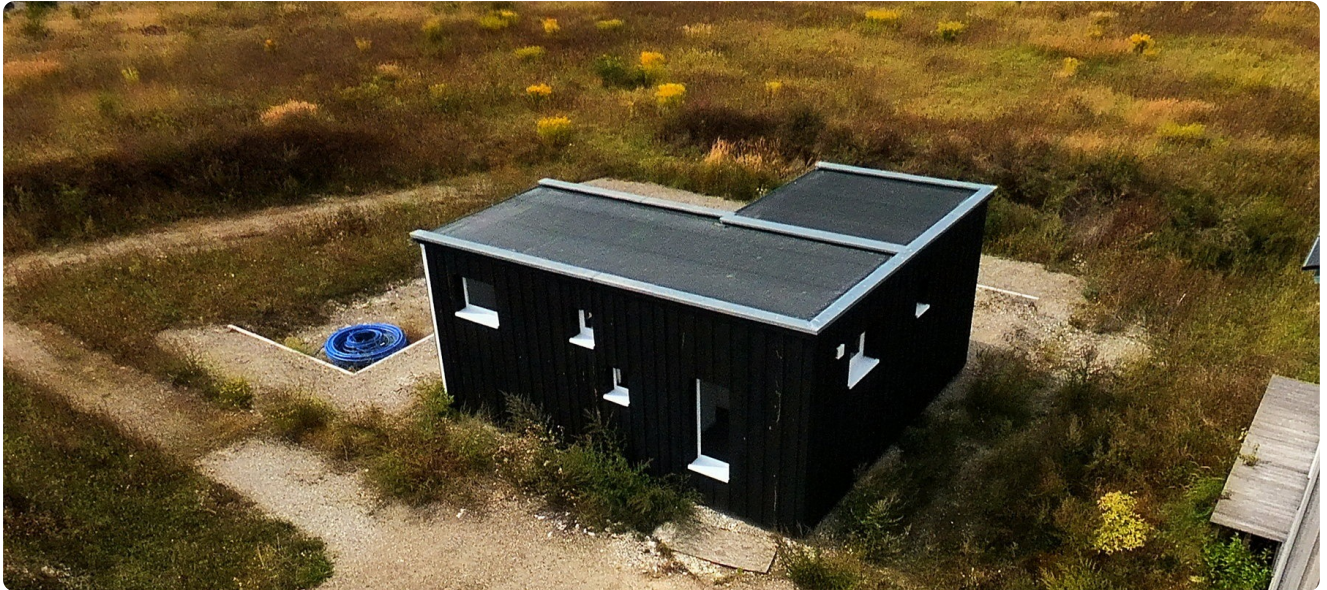
Luftbild des derzeitigen Standorts in Hannover. Das Haus wird ohne Grundstück veräußert.
