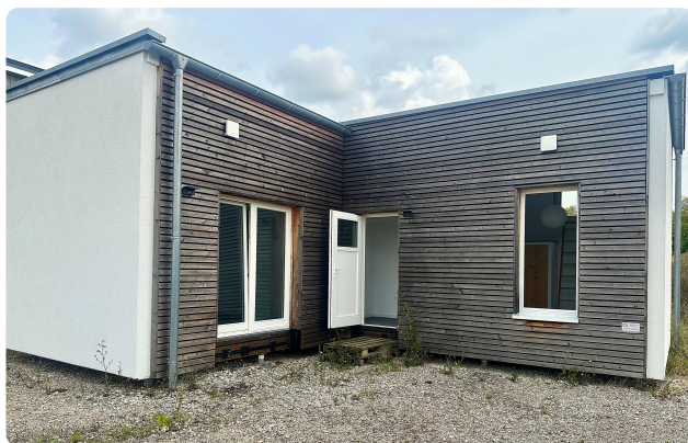
Eingangsseite mit hinterlüfteter Lärchenholzfassade.
