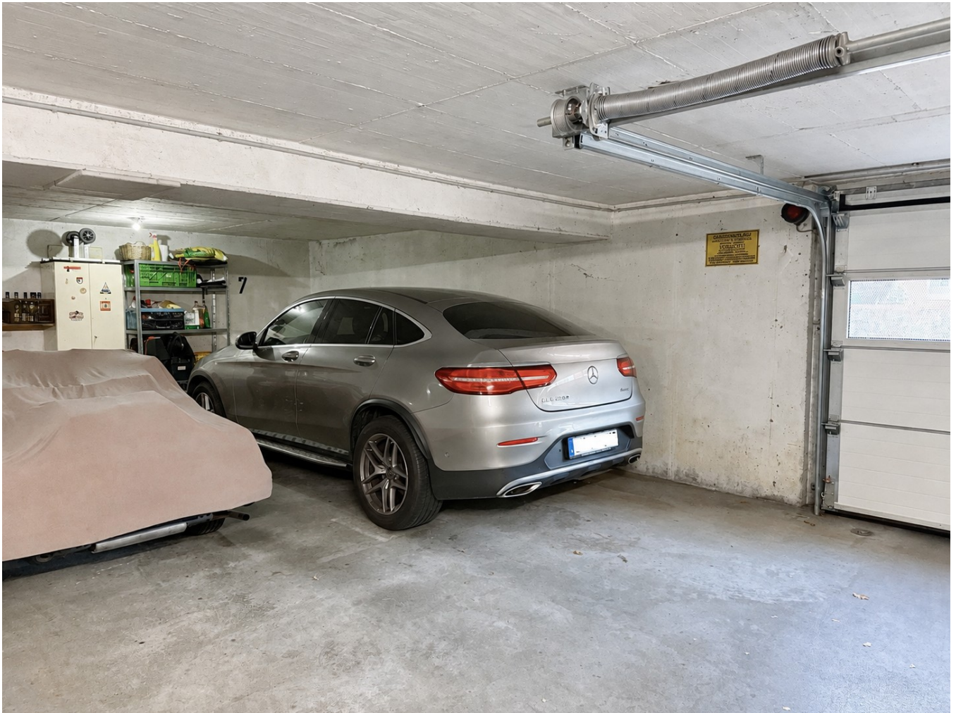
Tiefgarage der Wohnanlage
