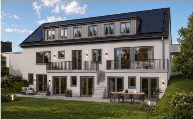
Gartenansicht mit Terrassen *
