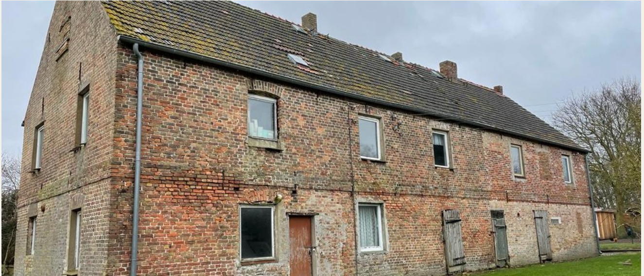
Gartenseite des Mehrfamilienhauses mit weitläufiger Rasenfläche – massive Ziegelbauweise um 1900.
