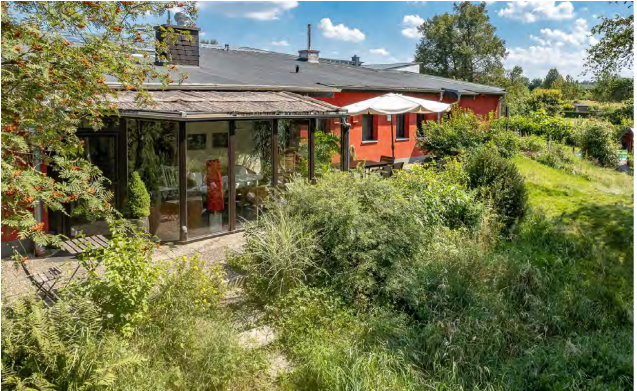
Westseite mit Wintergarten
