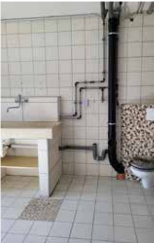
Technik- und Sanitärbereich
