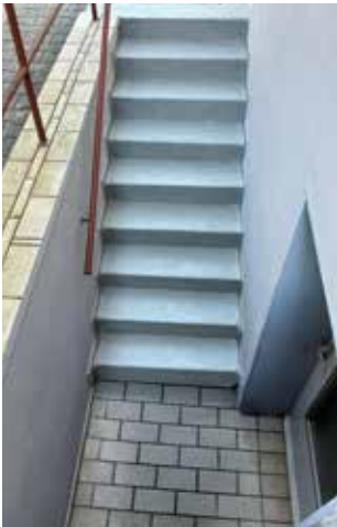
Außenzugang zum UG
