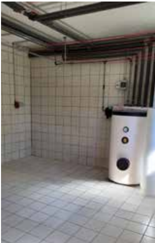
Technik- und Sanitärbereich
