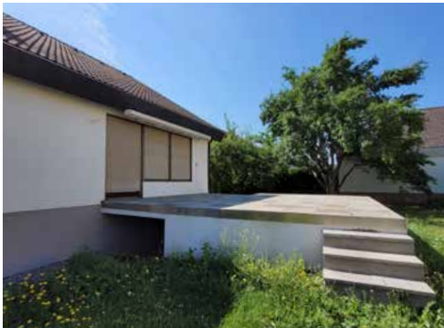
Fassade hinten / Terrassen- und Gartenbereich
