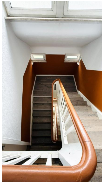
Treppenhaus, Blick von oben
