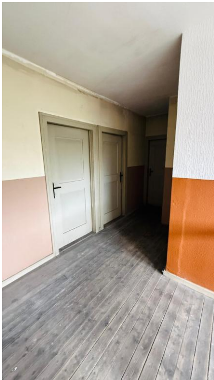
Flurbereich im Dachgeschoss
