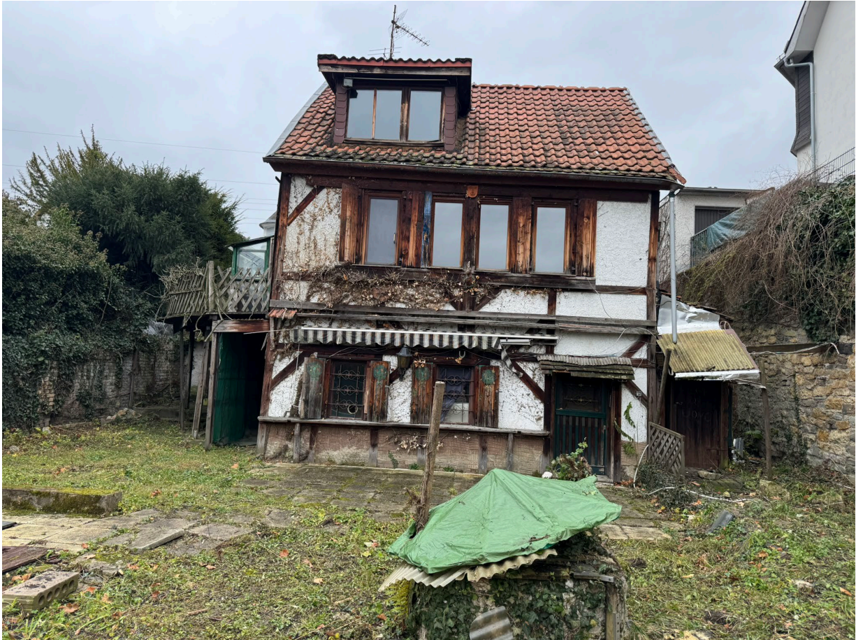
Bestandsgebäude vor der Verwertung; Besichtigungen sind nach Abstimmung möglich, das Grundstück ist durch einen Bauzaun gesichert.
