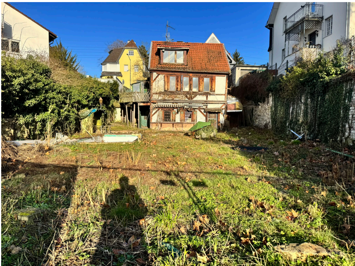
Straßenseitige Ansicht des gesicherten Grundstücks während der Freistellungsarbeiten.
