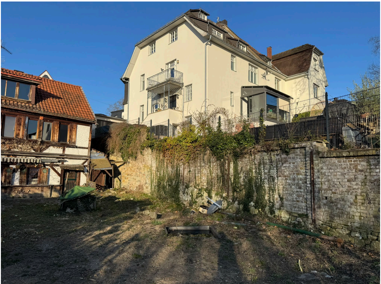
Die bestehende Hangkante und die mehrgeschossige Nachbarbebauung verdeutlichen die besondere topografische Situation.
