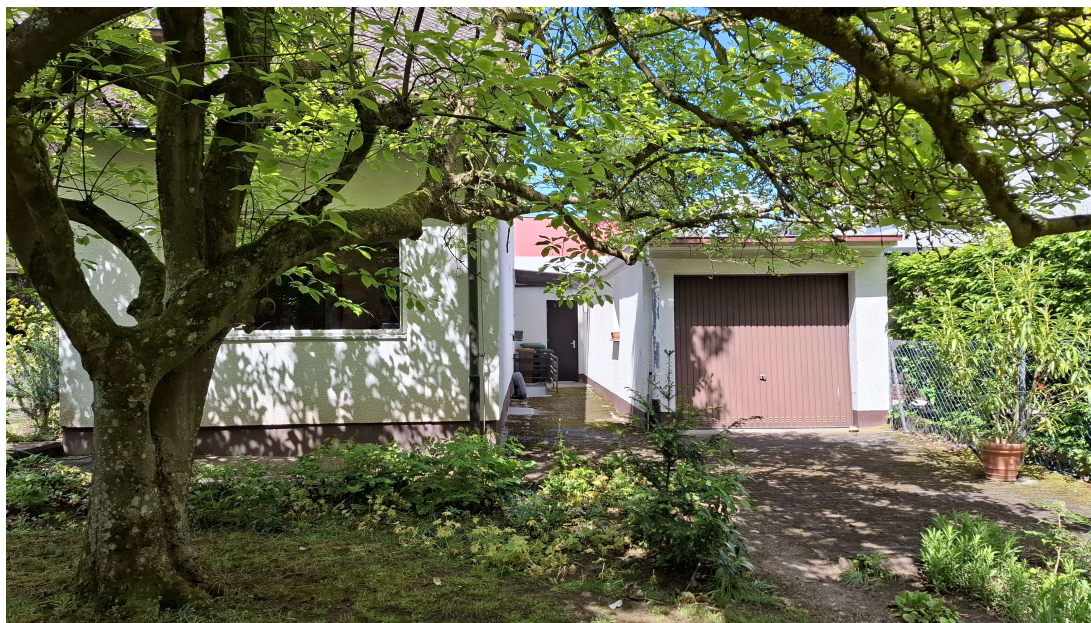
Rückseite Garage mit Stellplatz
