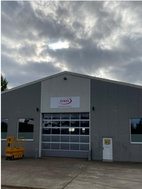
Außenansicht der Halle
