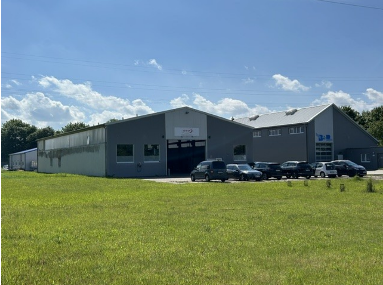
Außenansicht der Halle mit Stellplätzen
