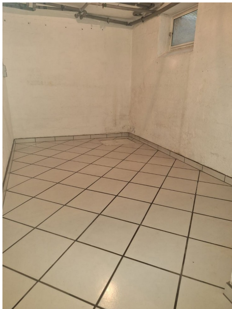
Abstellraum (Keller) – Ist-Zustand
