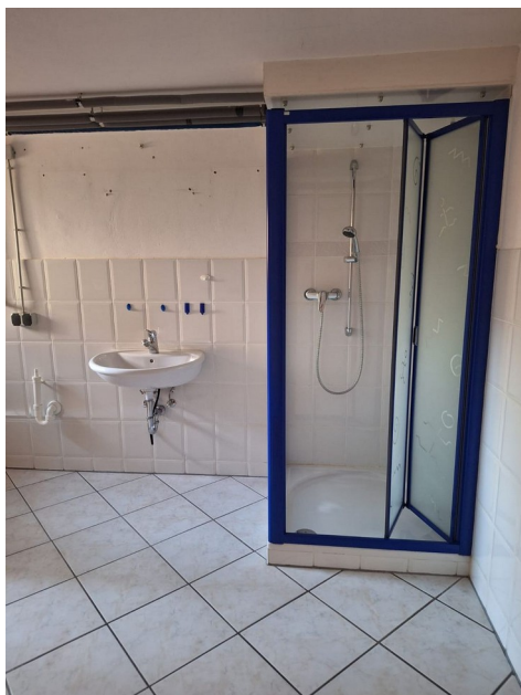
Waschraum mit Dusche (Keller) – Ist-Zustand
