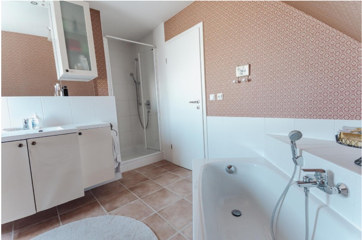
Bad im OG mit Fußbodenheizung
