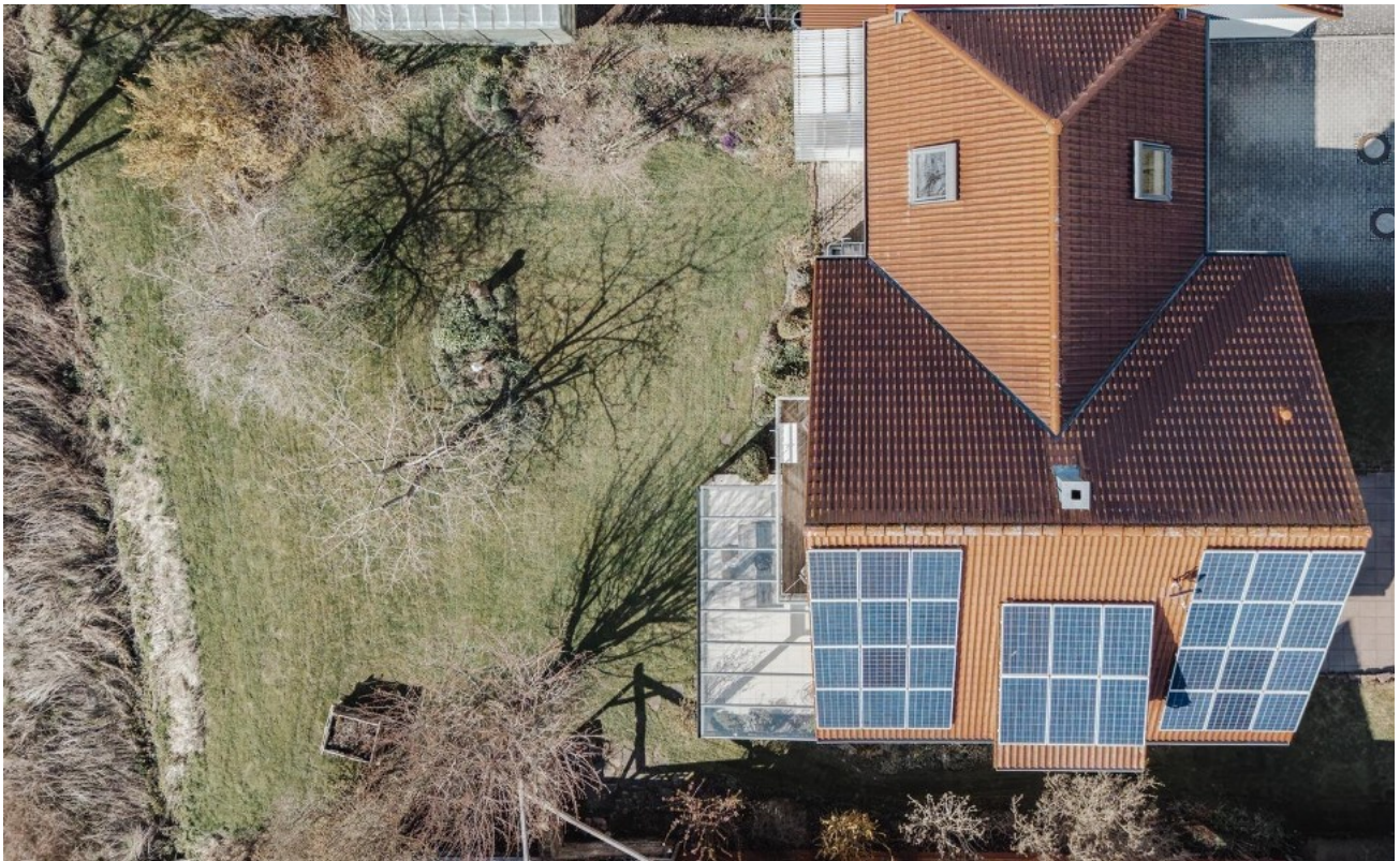
Dach mit Photovoltaik
