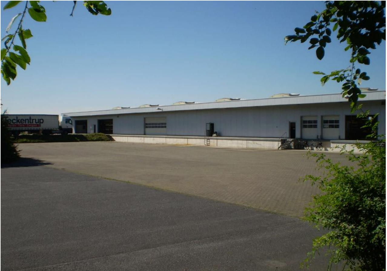
Halle außen – Rampenanlage und Tore Ost
