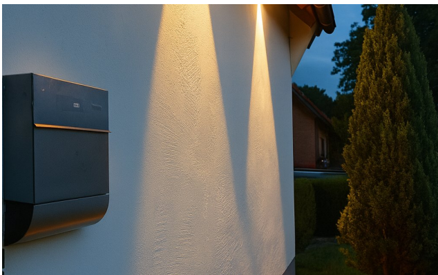
FASSADE 2024 FRISCH GESTRICHEN
