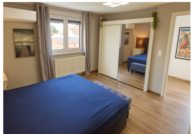
SPLIT-KLIMAGERÄT IM OBERGESCHOSS
