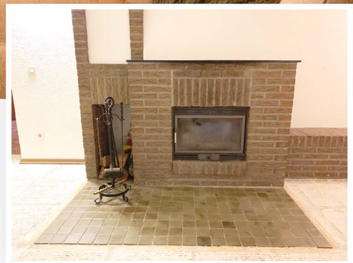
Ist-Zustand bei Einzug Mieter
