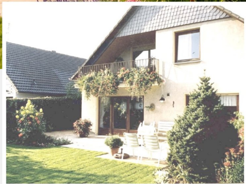
Ist-Zustand bei Einzug Mieter
