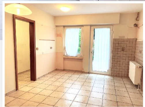
Ist-Zustand bei Einzug Mieter
