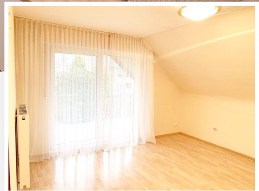
Ist-Zustand bei Einzug Mieter
