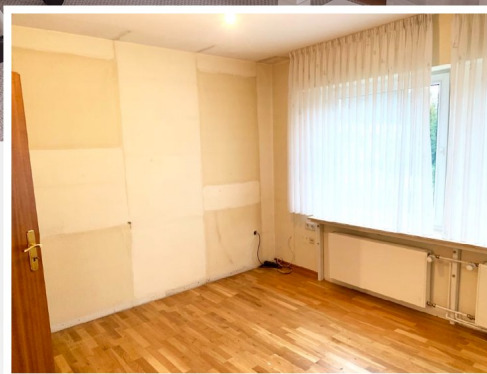
Ist-Zustand bei Einzug Mieter
