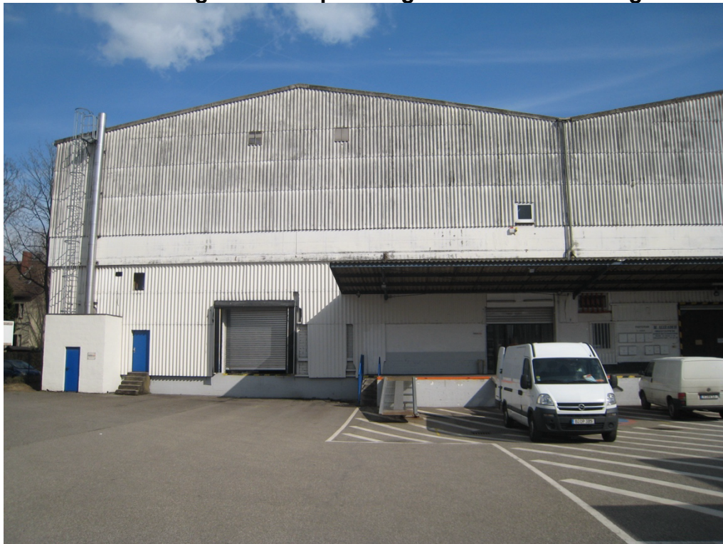
Halle 1 mit vorgelagerter Rampe
