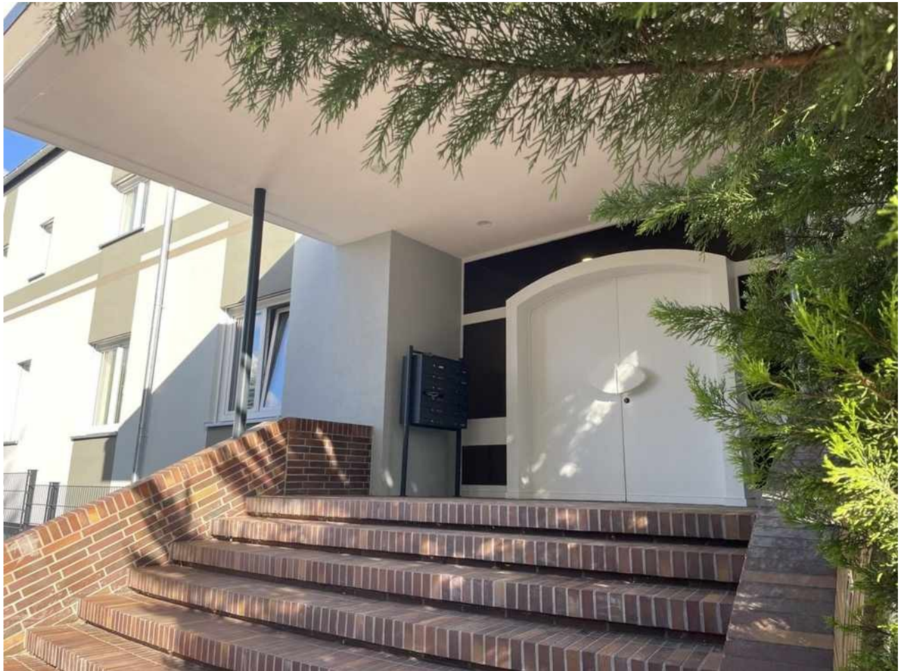
Eingangsbereich des Objekts
