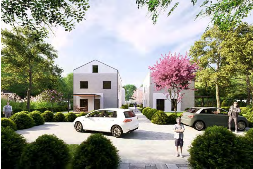
Ansicht Westen Straße Finkenweg
