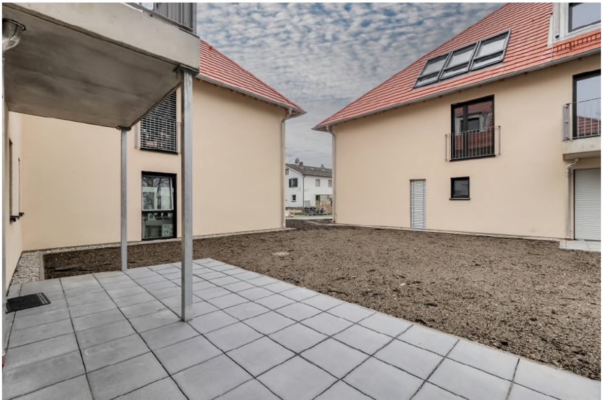
Terrasse | Aktueller Baufortschritt
