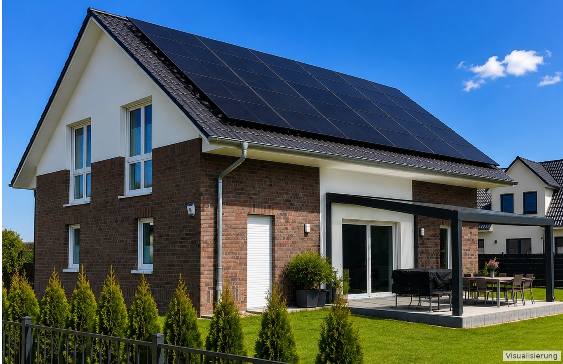
Freistehendes Viebrock-Massivhaus mit Photovoltaikanlage – Gartenansicht
