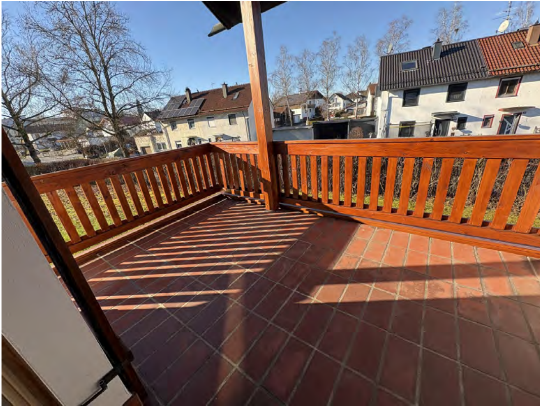
Balkon beim Wohnzimmer
