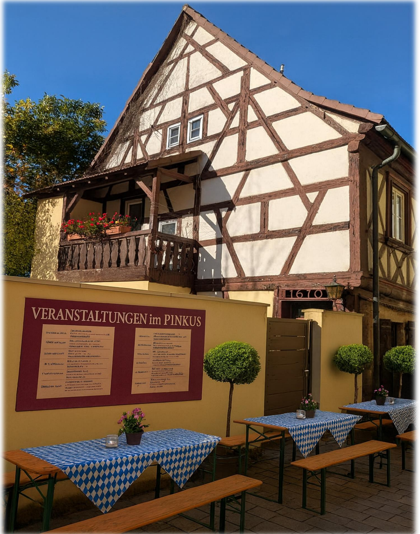
Ansicht hinten mit Innenhof
