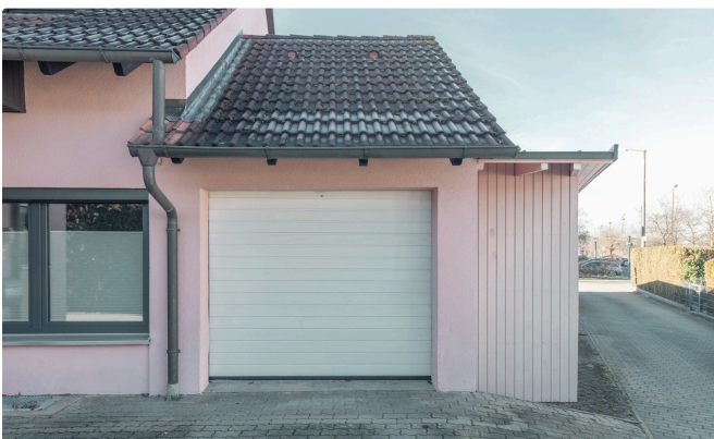
Garage mit elektrischem Tor
