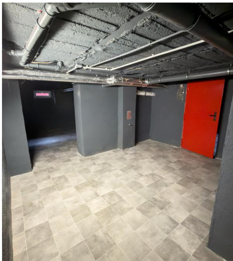
EINGANGSBEREICH DES KELLERGESCHOSSES
