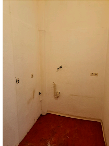
Hauswirtschaftsraum mit Waschmaschinenanschluss
