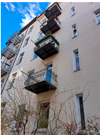
Blick auf Balkon der Wohnung vom Hof
