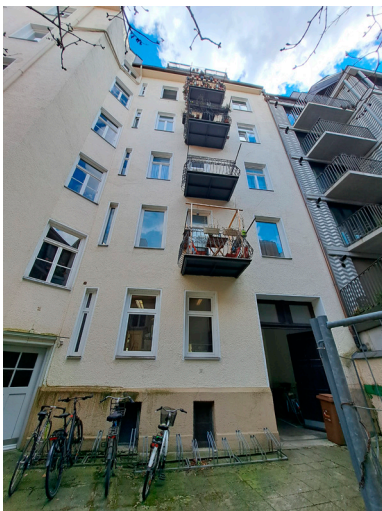
Fassade Erhardtstr. 11 zum Hof 1
