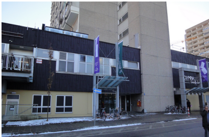
Nordseite OEZ mit Eingang Haus 65
