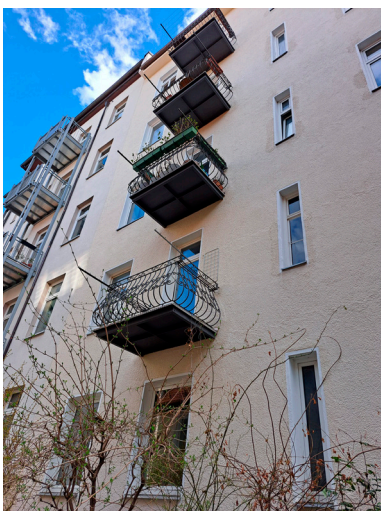
Blick auf Balkon der Wohnung vom Hof
